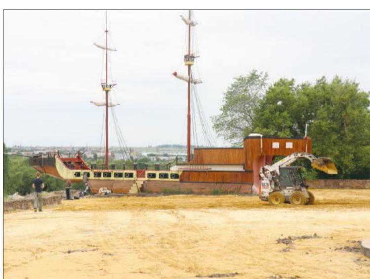
площадки для укладки брусчатки. Для укрепления грунта основания площадки сейчас выравнивается песчаное основание, затем ляжет бетонная подушка, ну и в завершении на всей территории площадки будет уложена брусчатка. Как отмечает подрядчик, это достаточно длительный процесс, поскольку необходимо всё выровнять по уровню, рабочие стараются использовать каждый благоприятный, без погодных катализмов час, чтобы своевременно провести все плановые работы.
